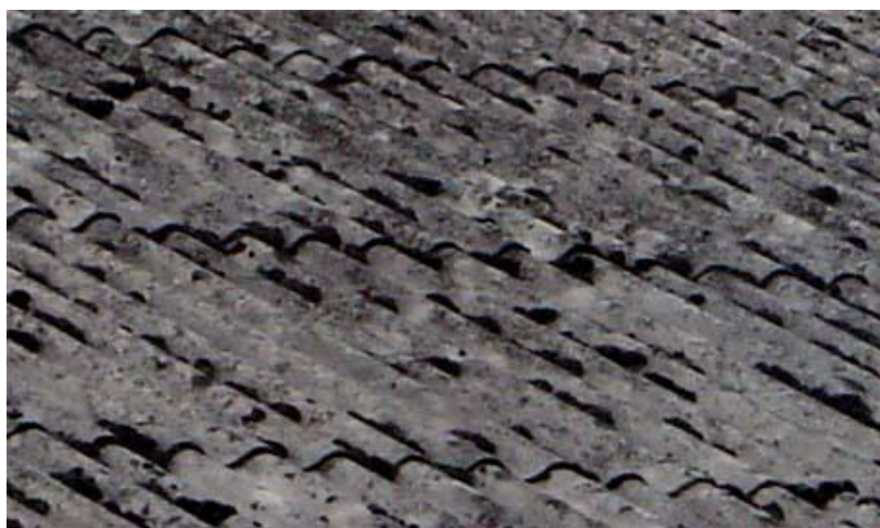
Pokrycie dachowe z płyt azbestowo-cementowych
